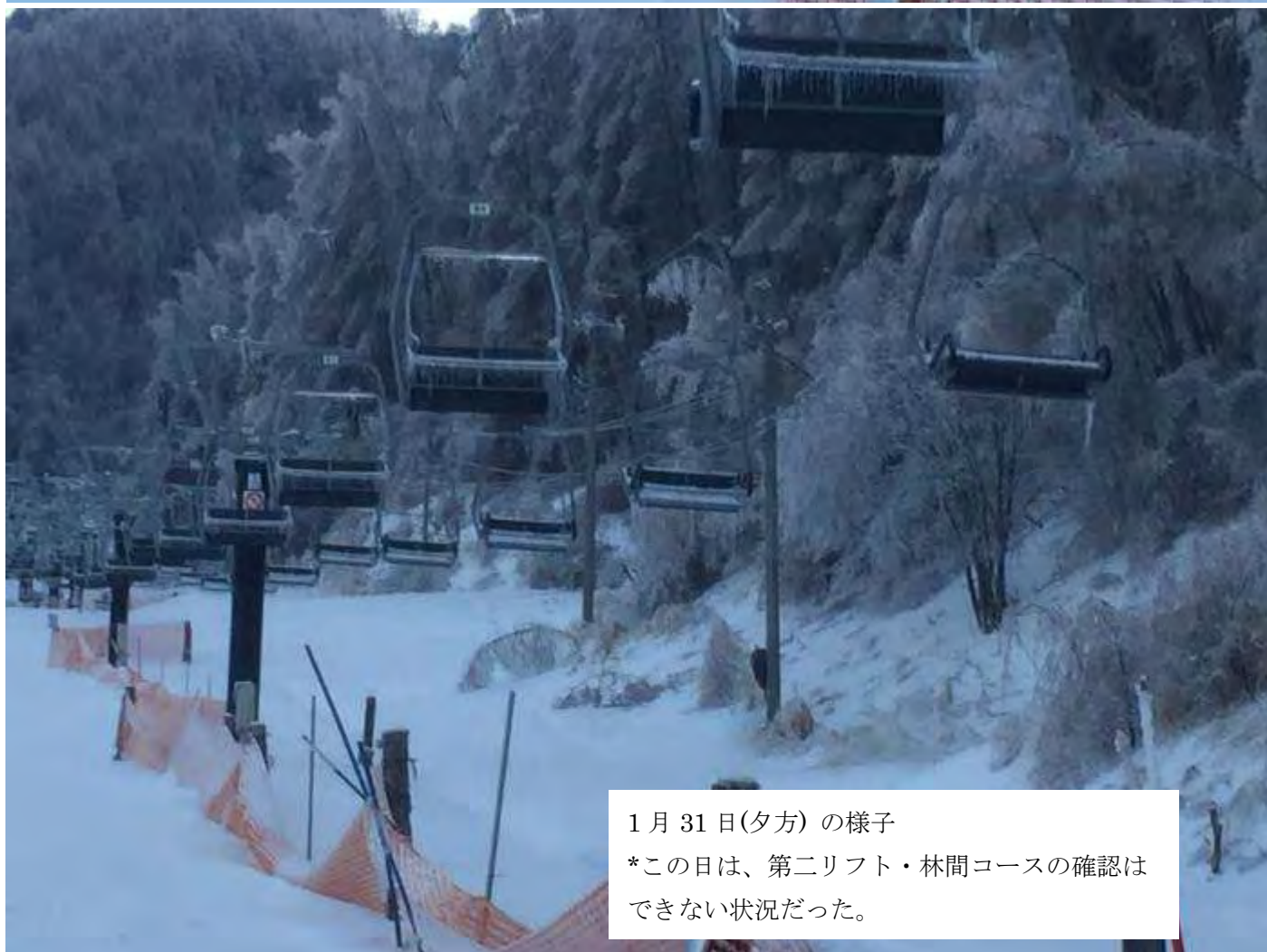
1月31日(夕方)の様子 第一リフト4号柱付近 リフトに長いツララができていた
