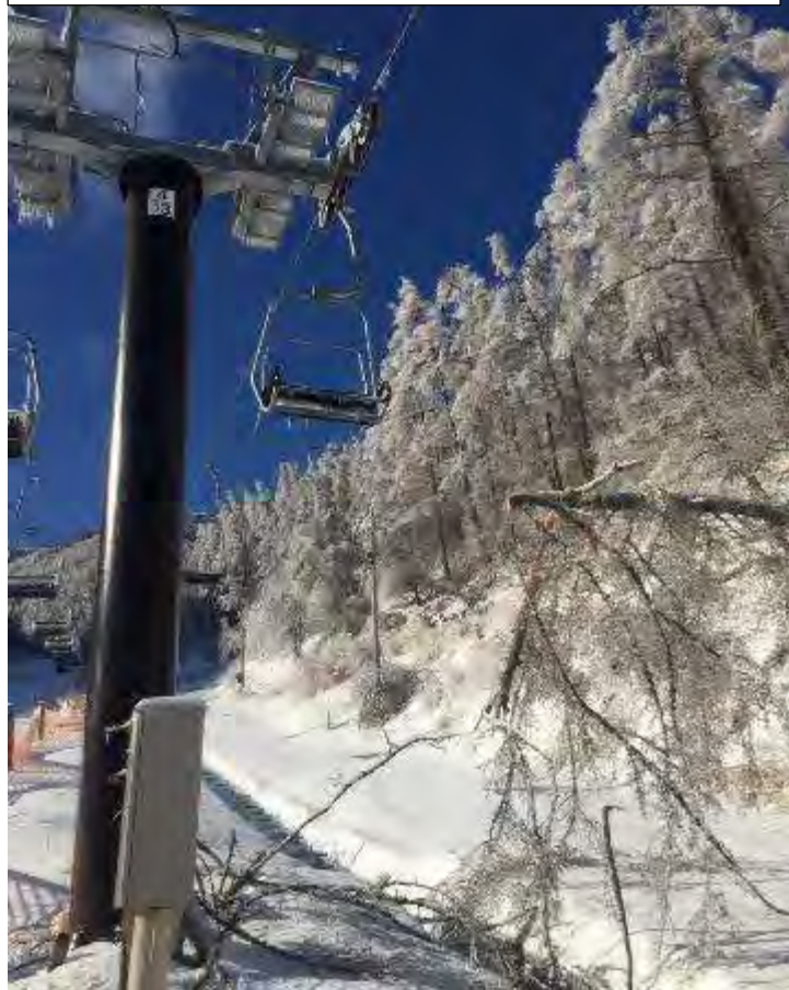
2/2AM 倒木撤去作業は、午後から始まる
